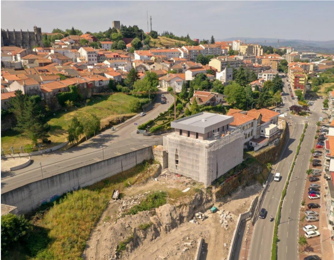
IV - Obras da Habitação Colaborativa
