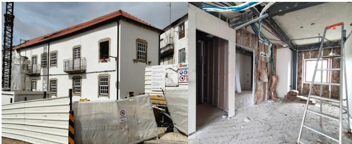
VI - Obra Alojamento Urgente e Temporário
