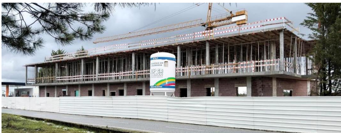
VII - Obra Unidade de Cuidados Continuados
